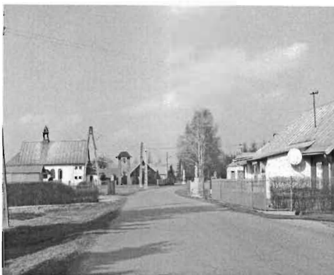
Foto. 1 – droga powiatowa, Kościół Filialny
